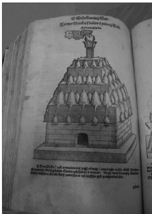
Obrázek 4: Pec pro mnohočetnou destilaci. Ilustrace z Matthioliho Herbáře. Praha, 1562. Zdroj: archiv autorky (snímek Jana Černá).
